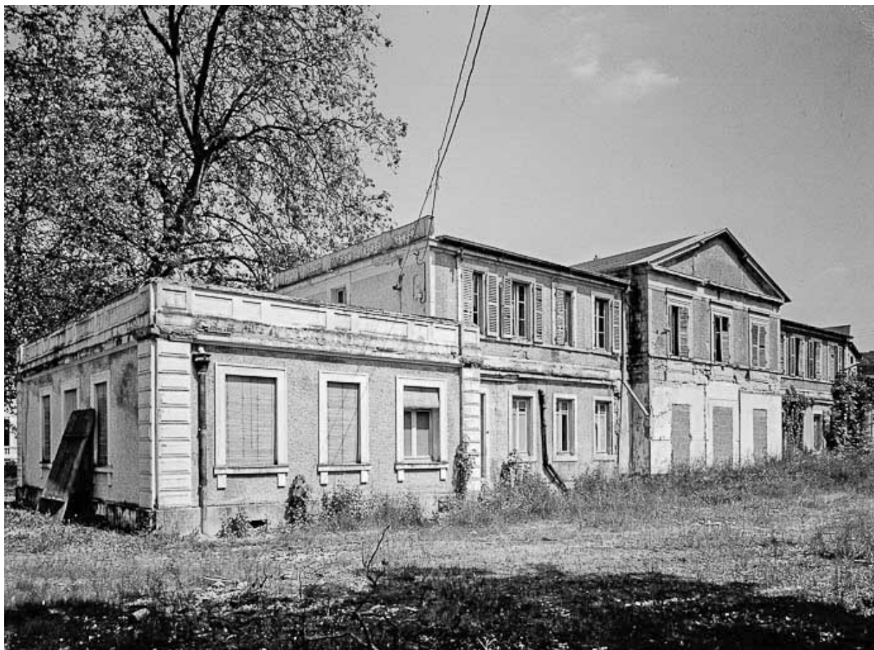
Façade postérieure, vue prise en 1984.
