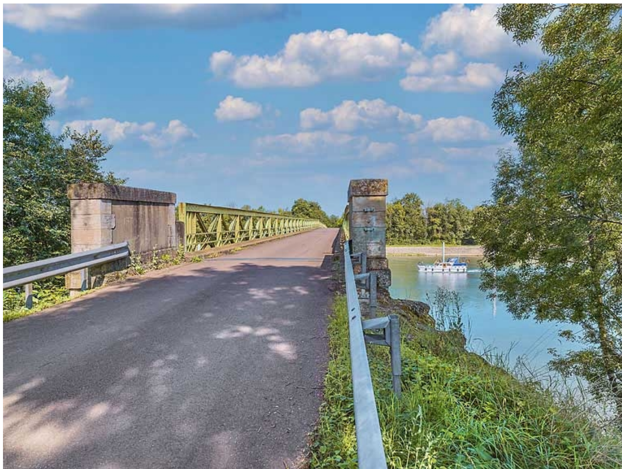
Vue du dessus du pont, rive gauche.
