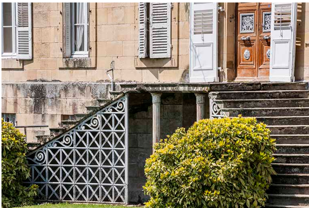
L'escalier double, façade sud.
