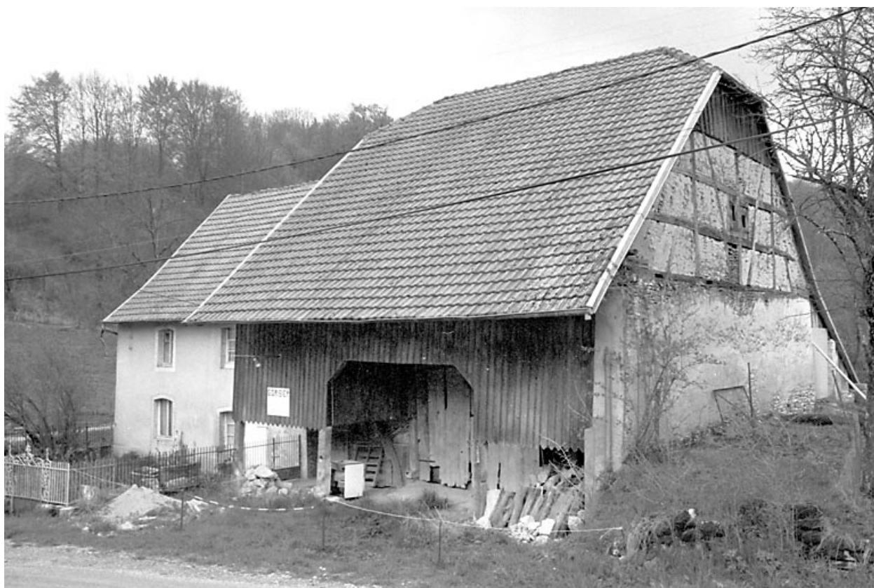
2e ferme : vue d'ensemble.
