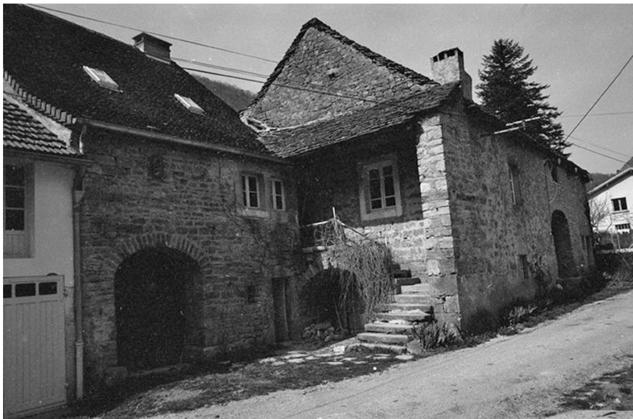
Ferme cadastrée 1964 AB : façade sur rue.
