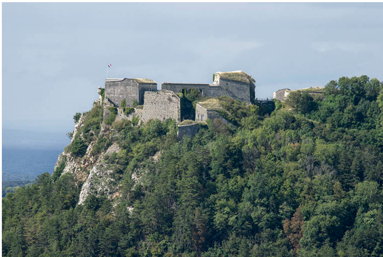
Fort Belin : vue générale du front sud.
