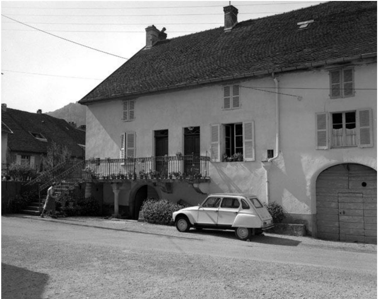
Façade antérieure vue de trois quarts.
