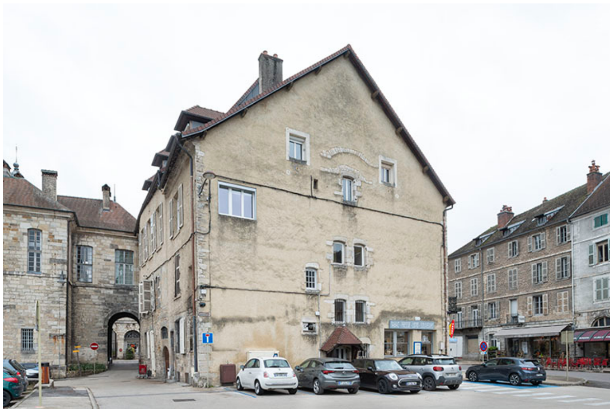
Mur pignon sud.
