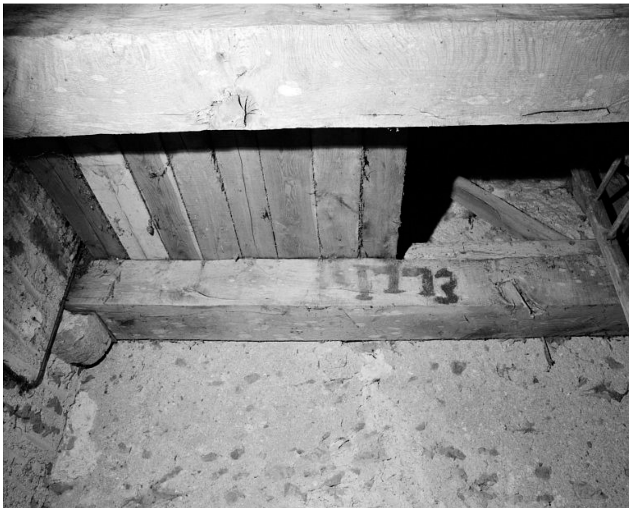
Clocher, poutres supportant le beffroi.
