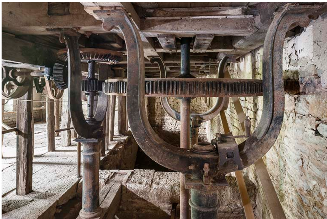
Etage de soubassement. Beffroi du moulin.
