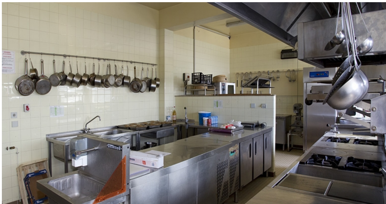
Bâtiment de l'hôtellerie : cuisine pédagogique (nord).
