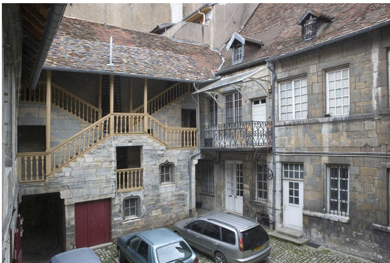
Vue d'ensemble de l'escalier à cage ouverte.
