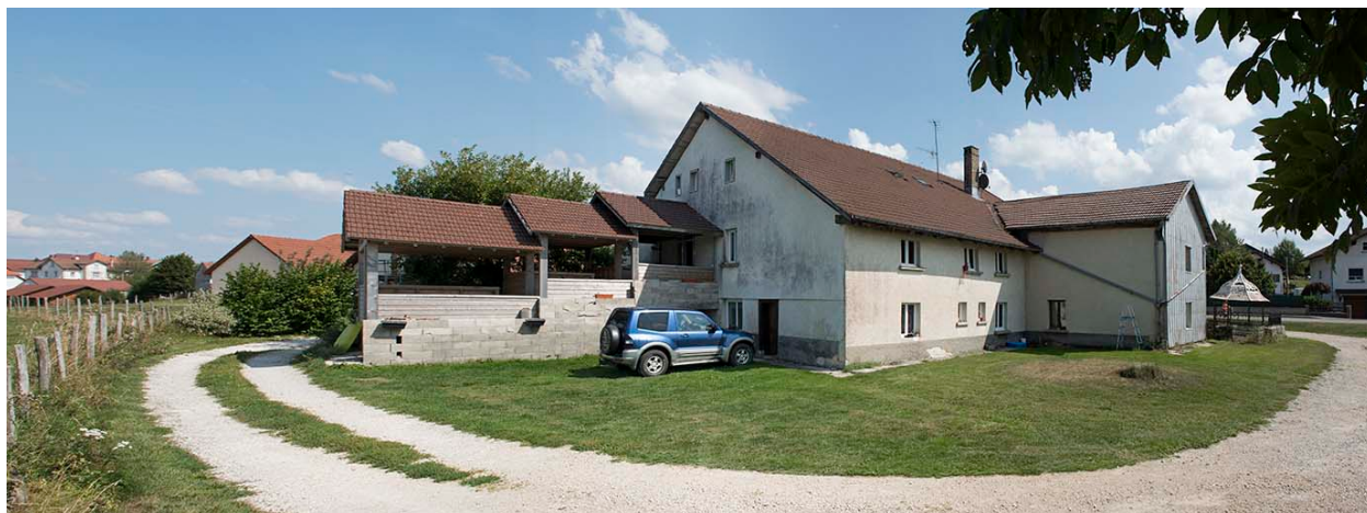
Façades postérieure et latérale gauche.
