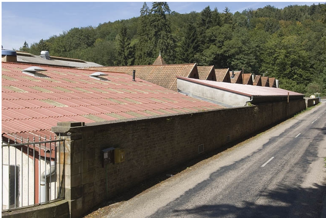
Toitures des ateliers le long de la route de Plombières.
