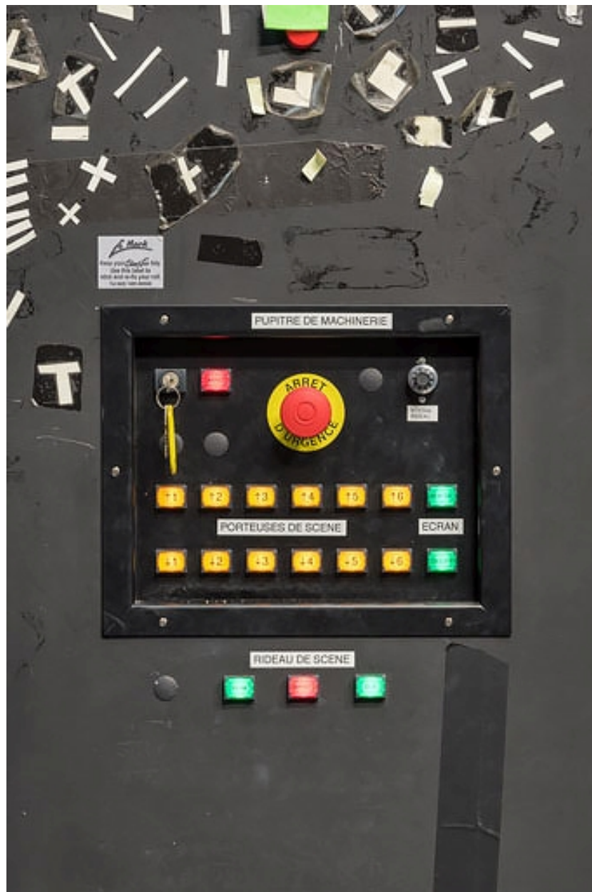
Pupitre de commande de la machinerie.
