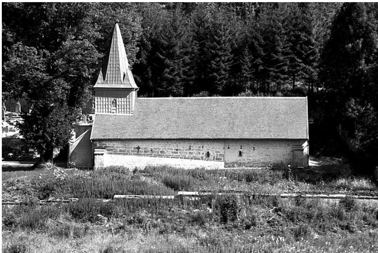
Façade latérale droite.
