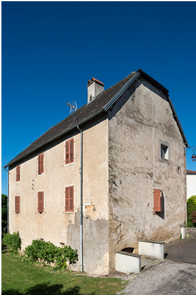
Vue de trois-quarts, façades postérieure et latérale.
