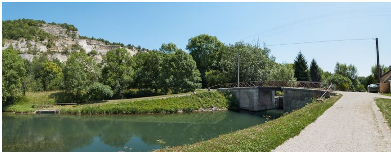
Pont vu d'aval.
