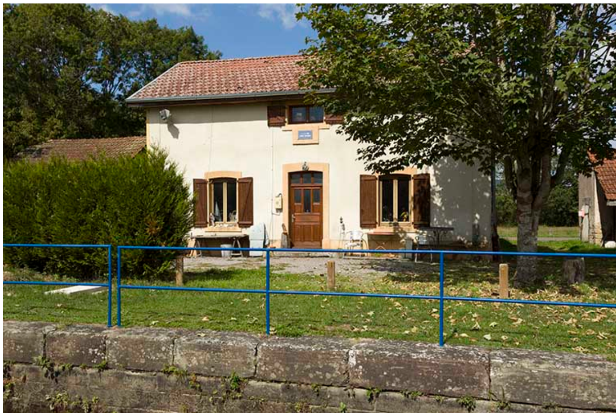
La maison d'éclusier, depuis l'écluse.
