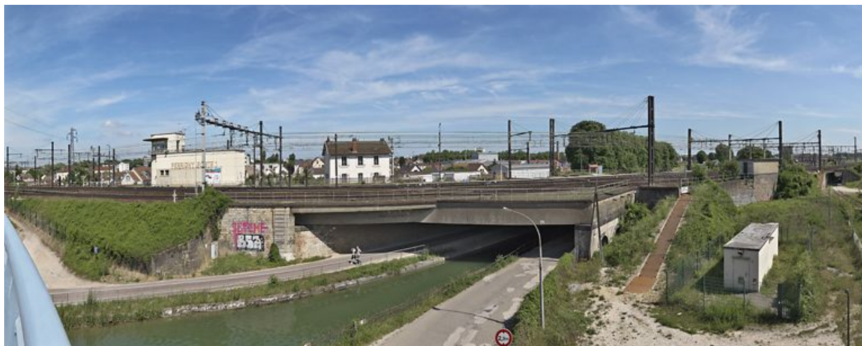
Pont ferroviaire isolé à Dijon.
