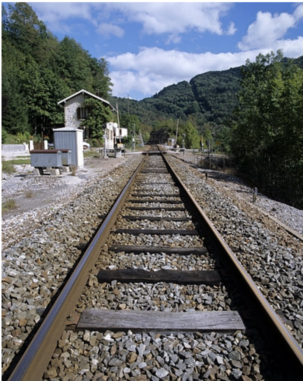
Exemple de voie avec traverses en bois.
