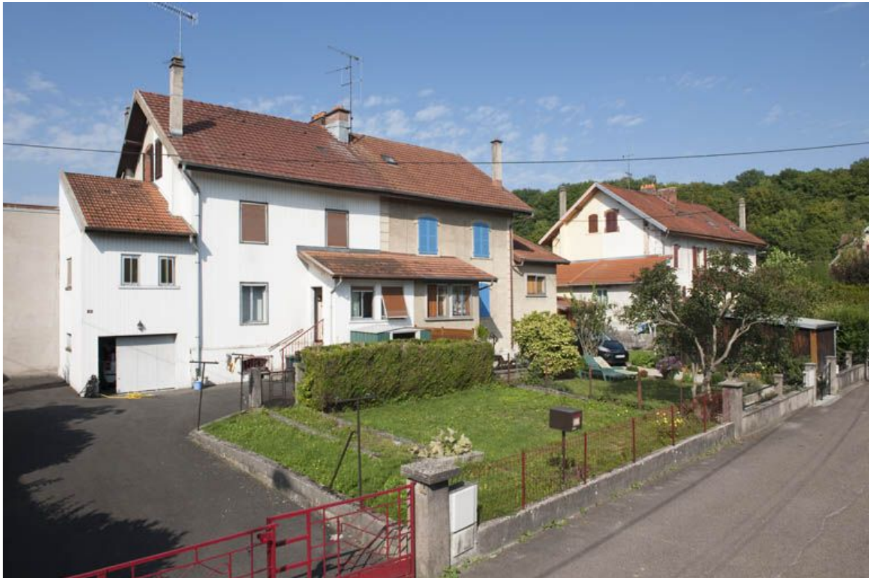
Habitations à 4 logements vues de trois quarts.
