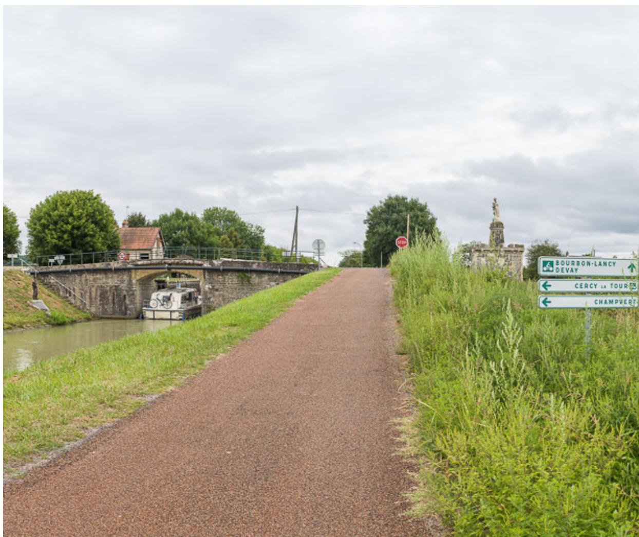
Vue du pont et du site.
