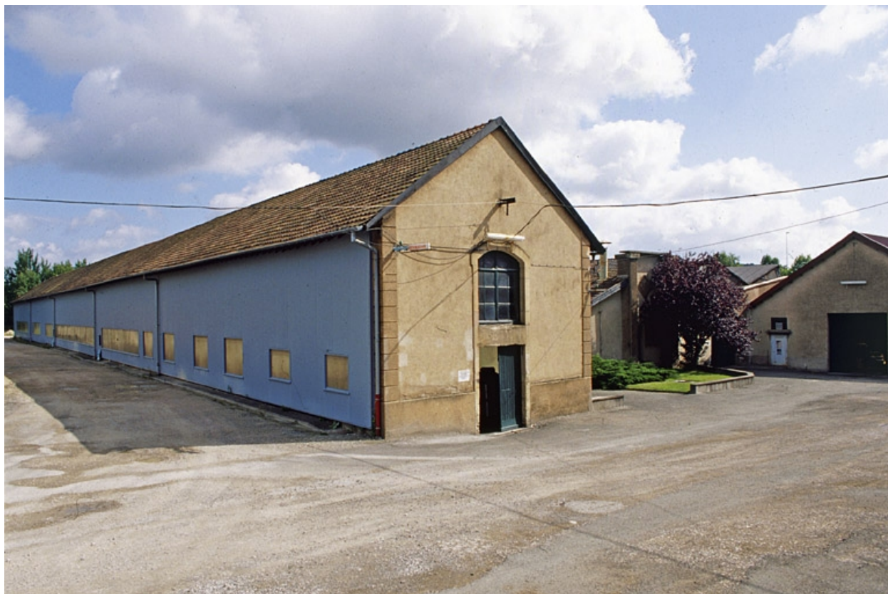
Atelier de fabrication (câblerie).
