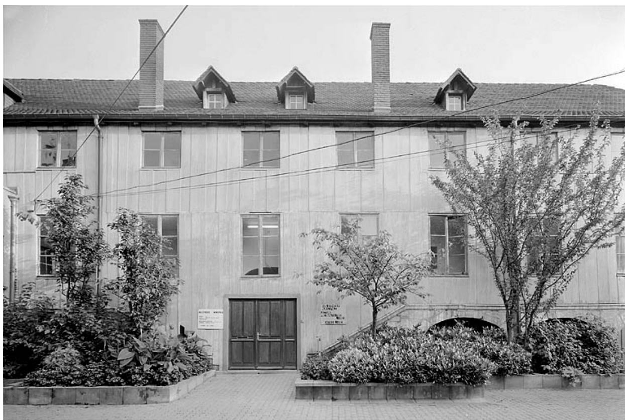
Façade sur cour.
