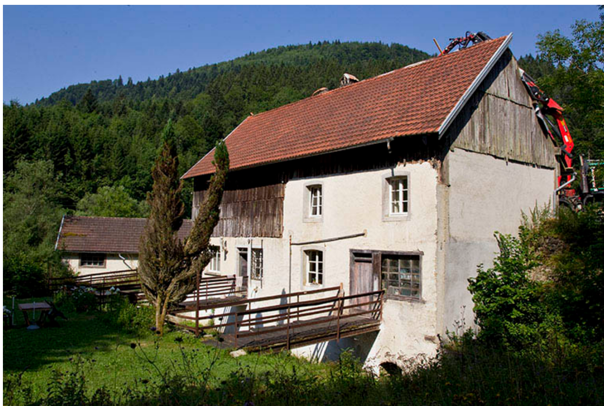
Scierie : façades postérieure et latérale gauche.
