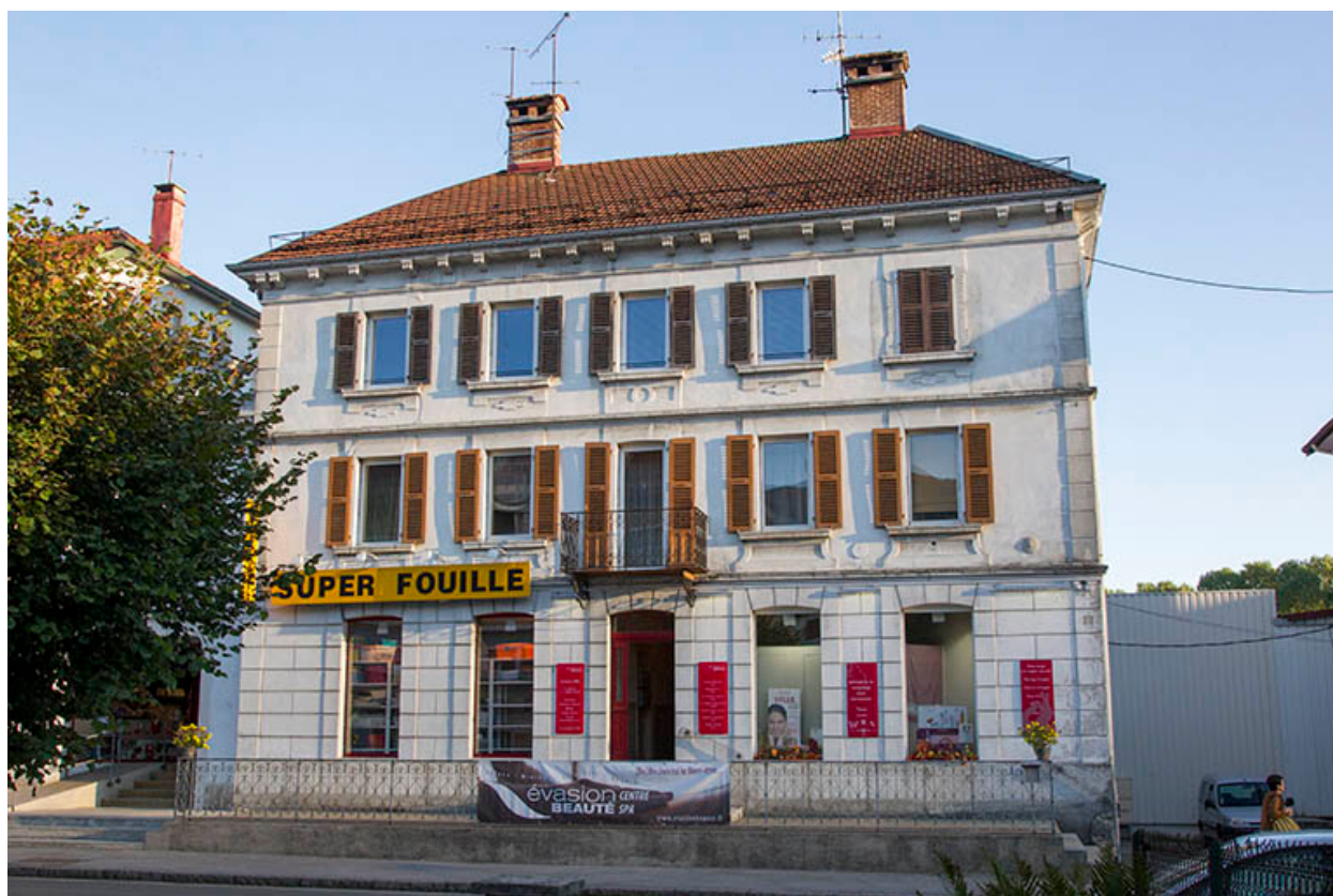
Immeuble au n° 13.
