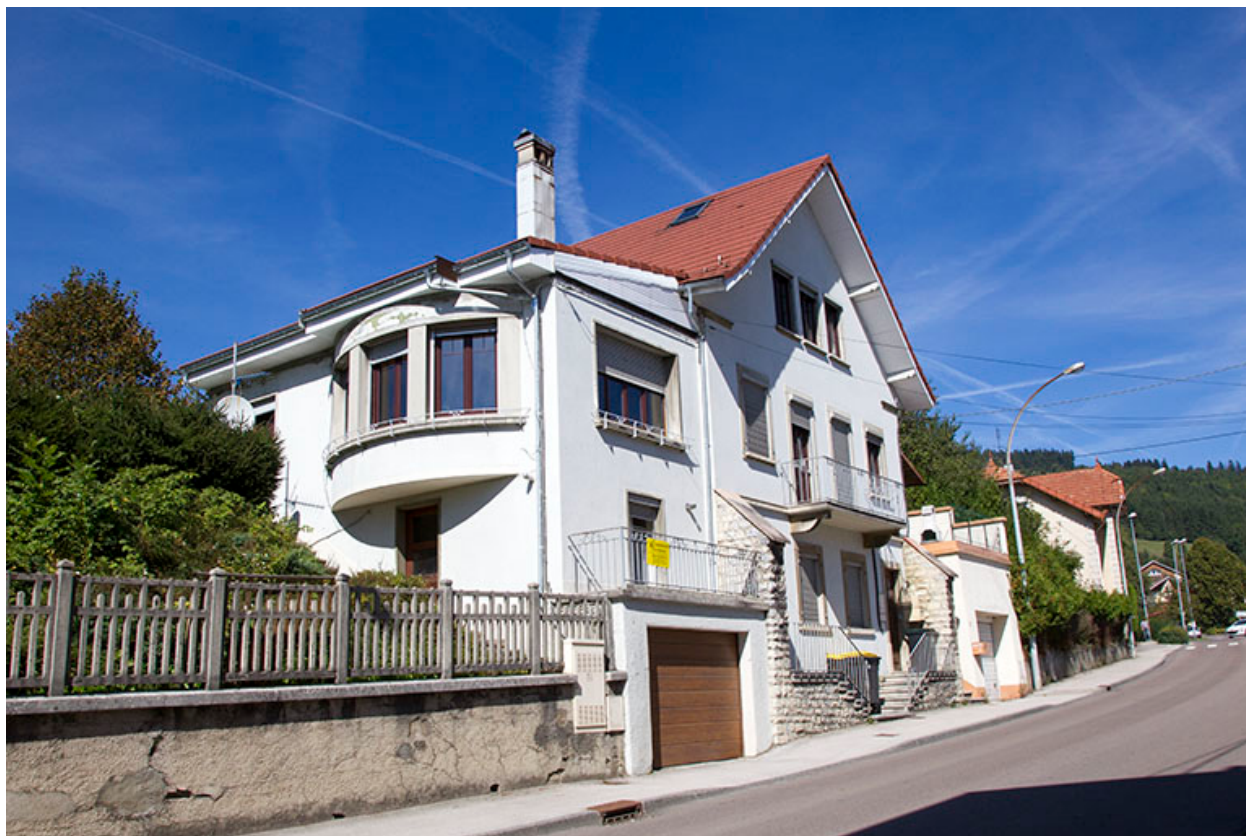
Façades antérieure et latérale gauche.
