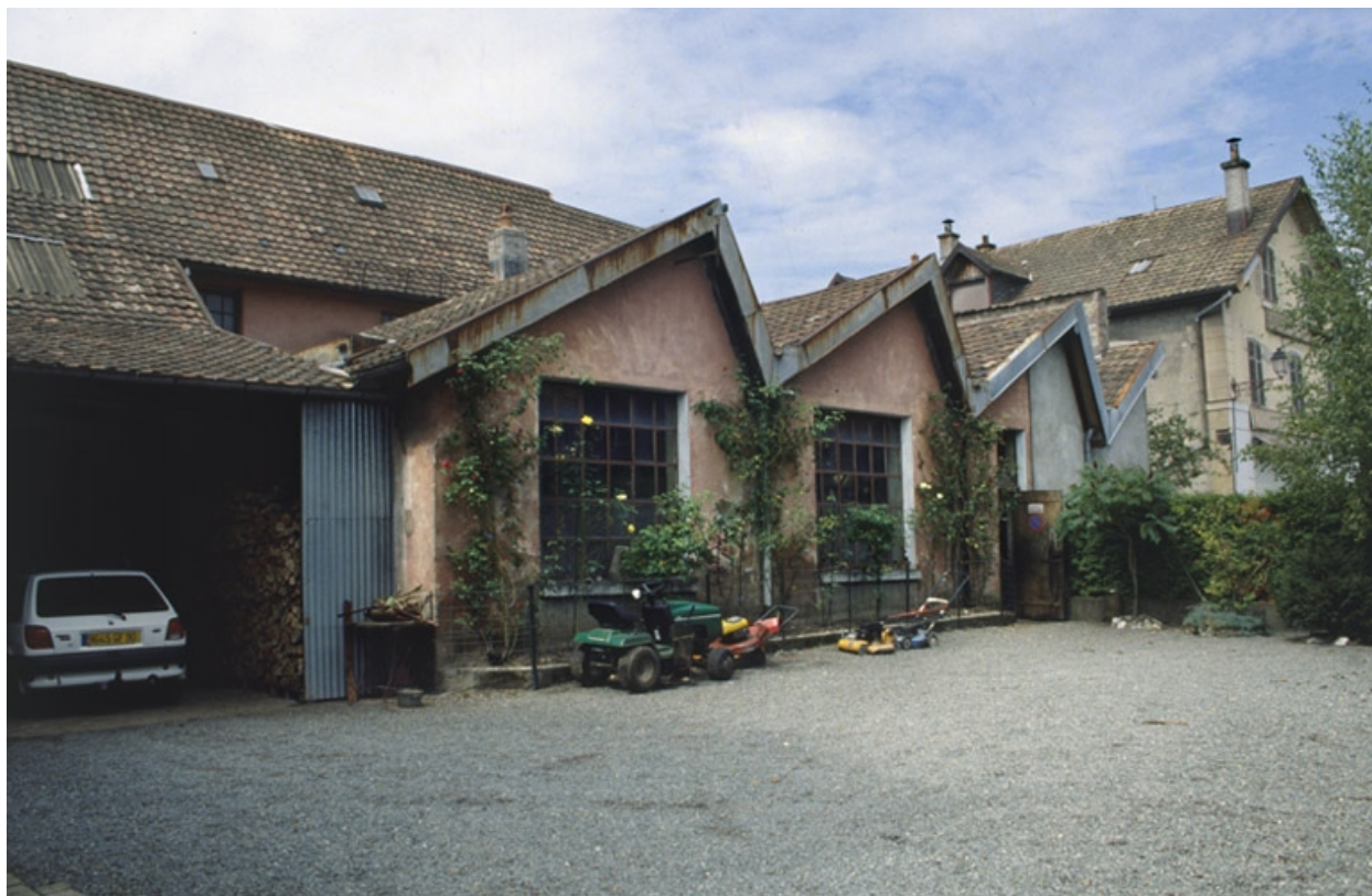
Sheds de l'atelier de fabrication.
