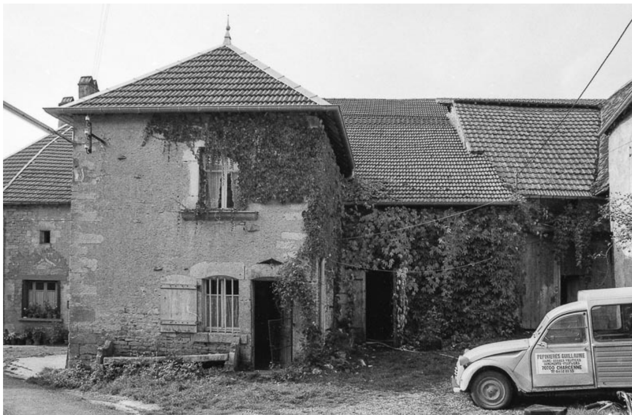
Ferme cadastrée 1958 C3 703 : façade antérieure.
