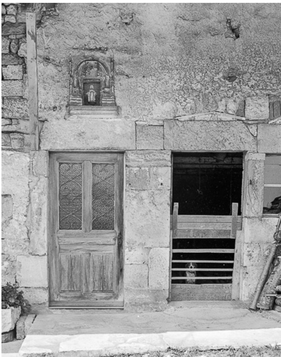
Ferme : détail des ouvertures sur rue.
