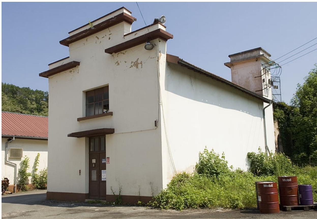
Ancien bâtiment d'eau et transformateur.
