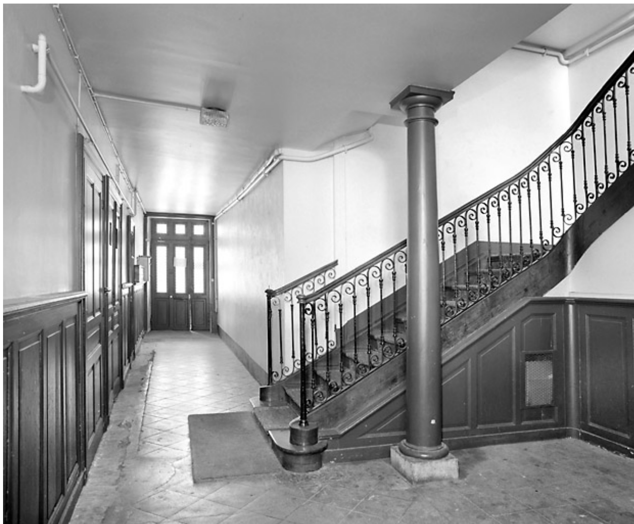
Couloir et escalier tournant.
