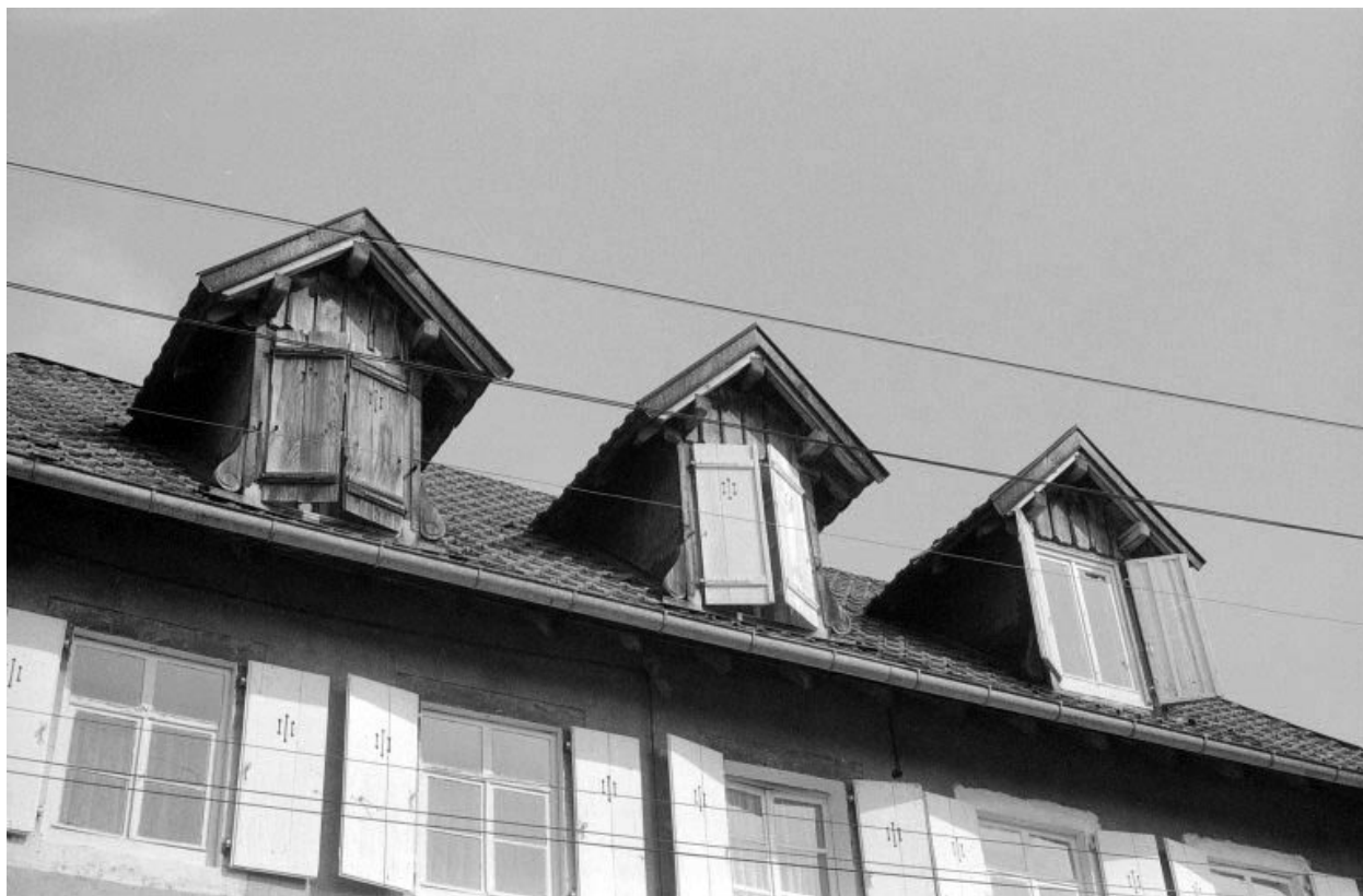
Façades antérieure : détail des lucarnes.
