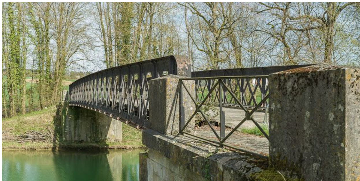
Le pont, vue d'ensemble.
