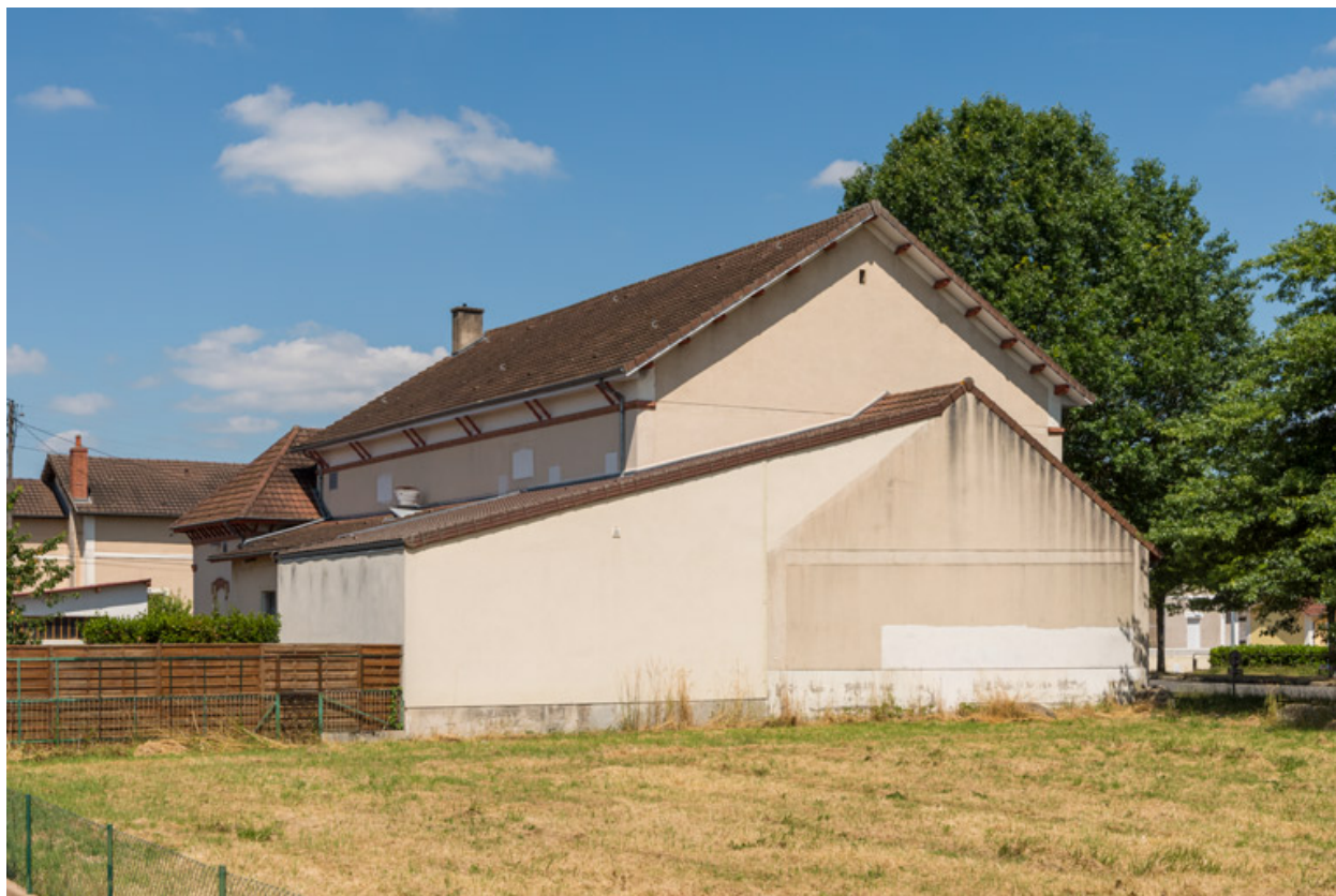
Façades postérieure et latérale droite.
