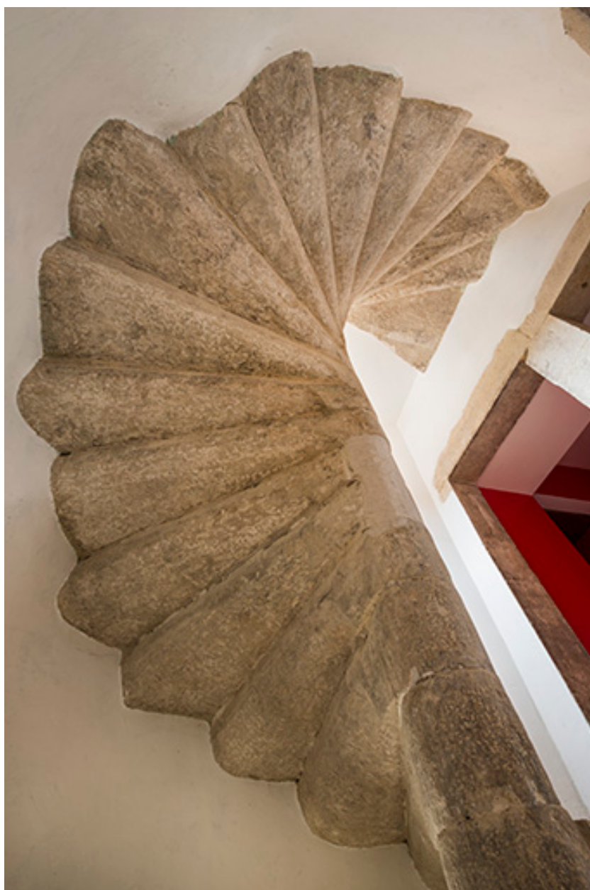
Vue en contre-plongée de l'escalier.
