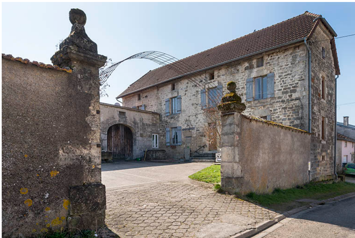
Maison située Grande rue.
