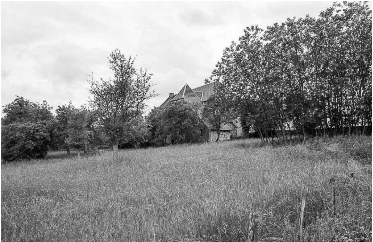
Façade postérieure des bâtiments.
