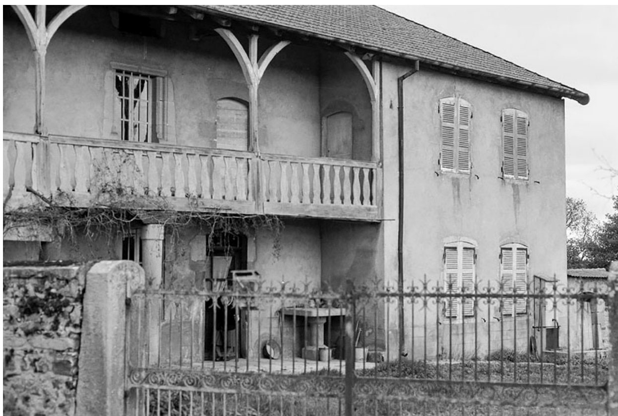
Vue de la maison, vers 1970
