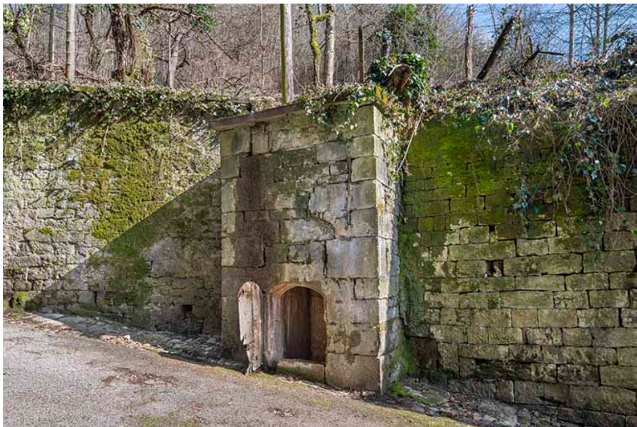
Escalier de Saint-Anatoile. Captage d'une source.
