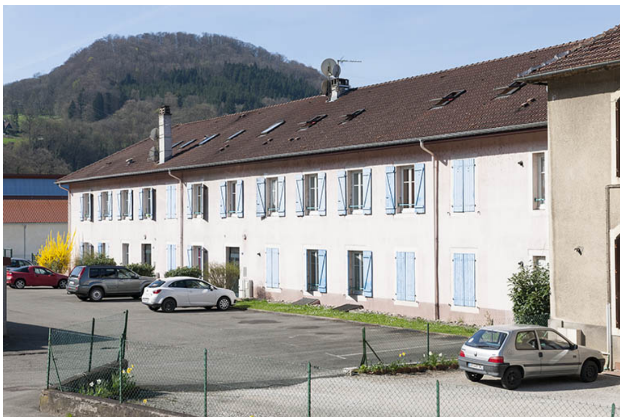
Bâtiment de bureaux (rive droite).
