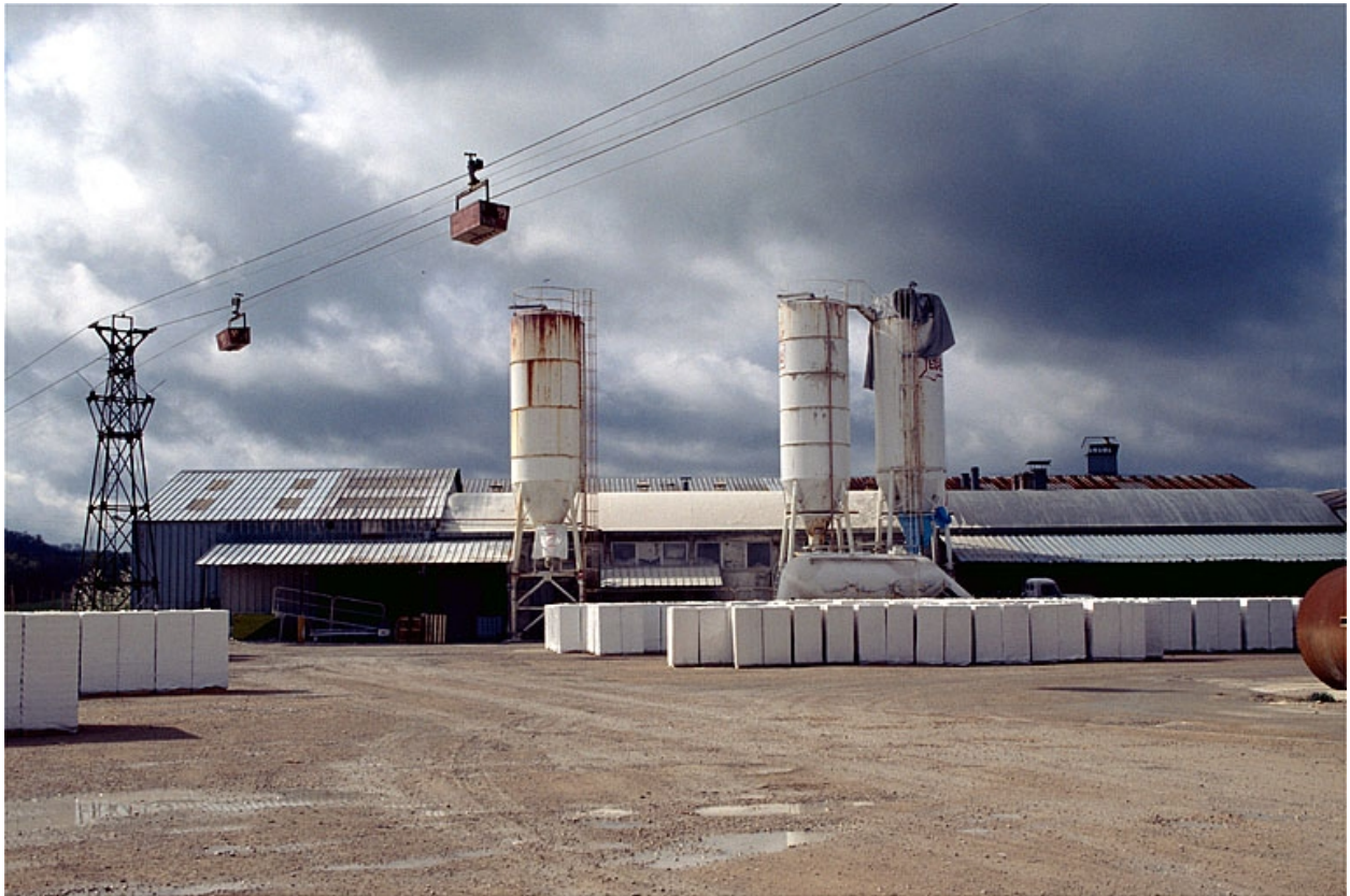
Plâtrières modernes de Grozon : usine et transporteur aérien.
