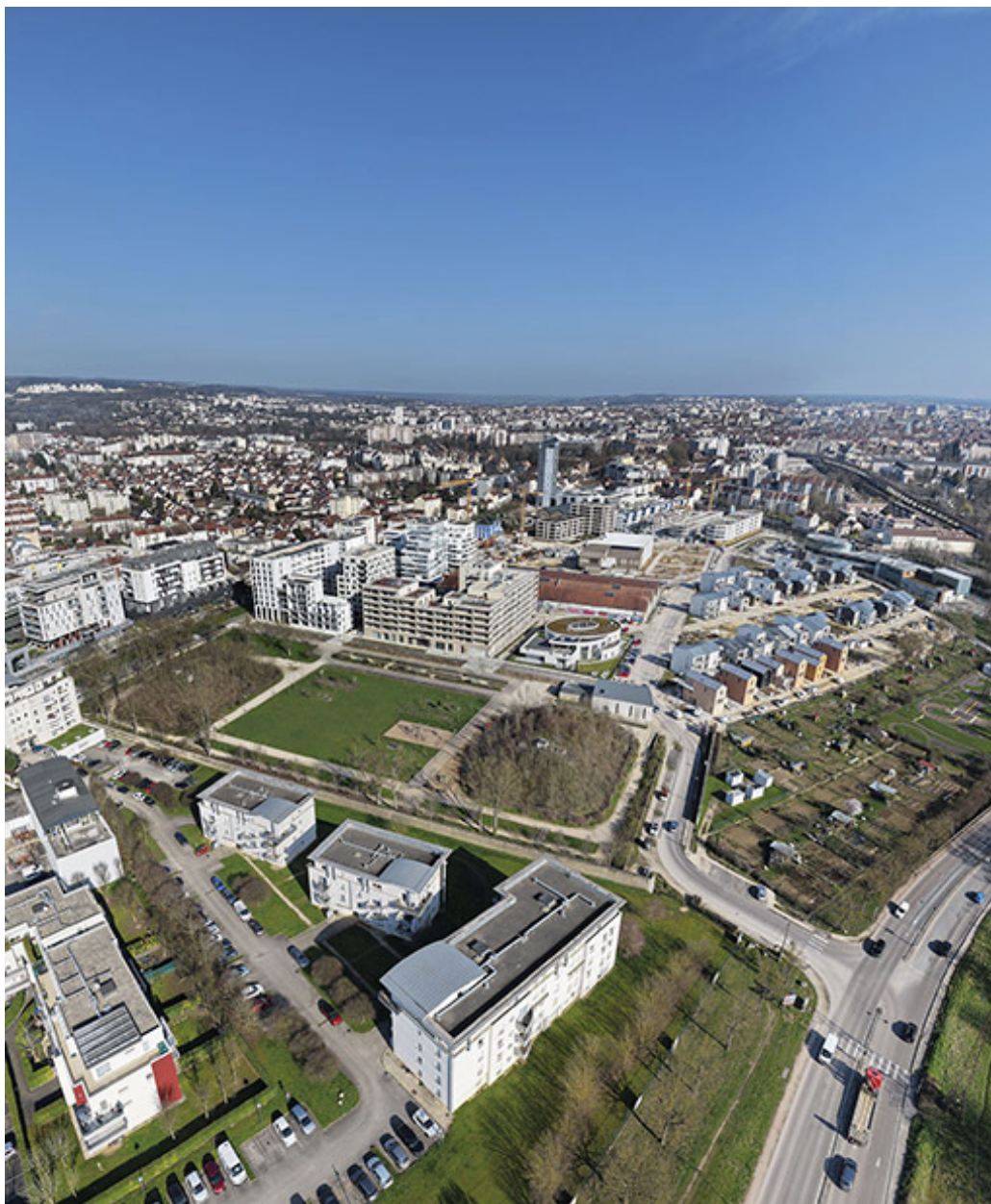
Site de l'ancien arsenal. (vue aérienne).
