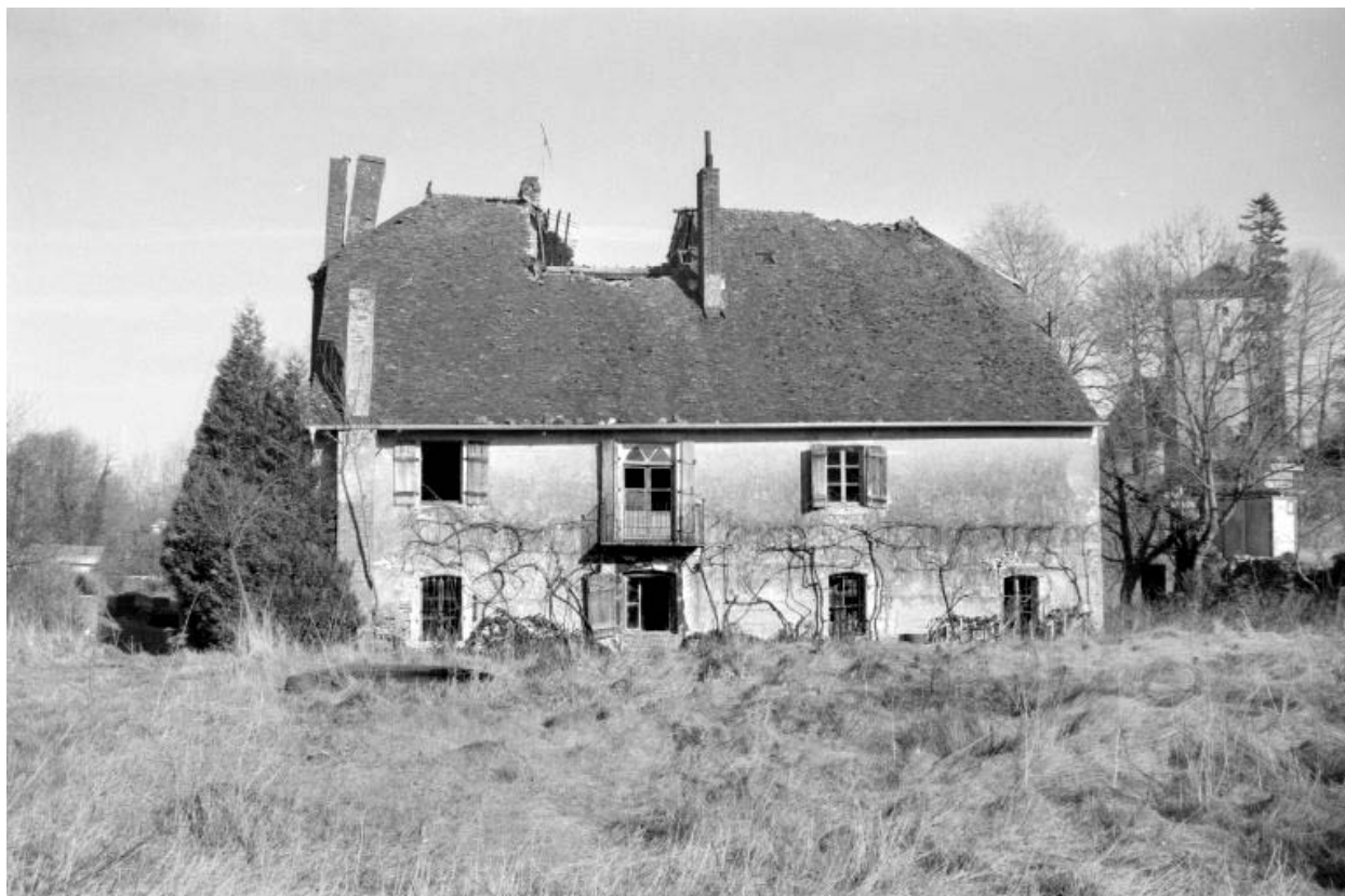
Façade postérieure du logement patronal.
