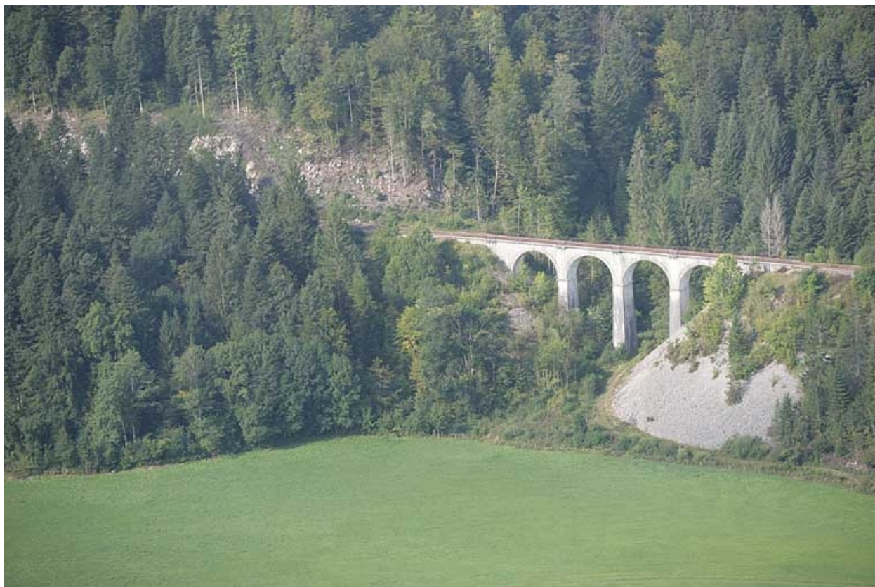
Vue aérienne, depuis le nord-est.
