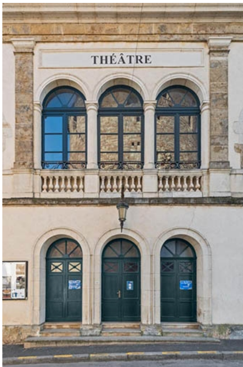
Façade antérieure : travées centrales.
