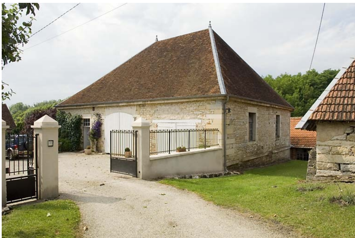
Le haut fourneau vu depuis le sud-est.
