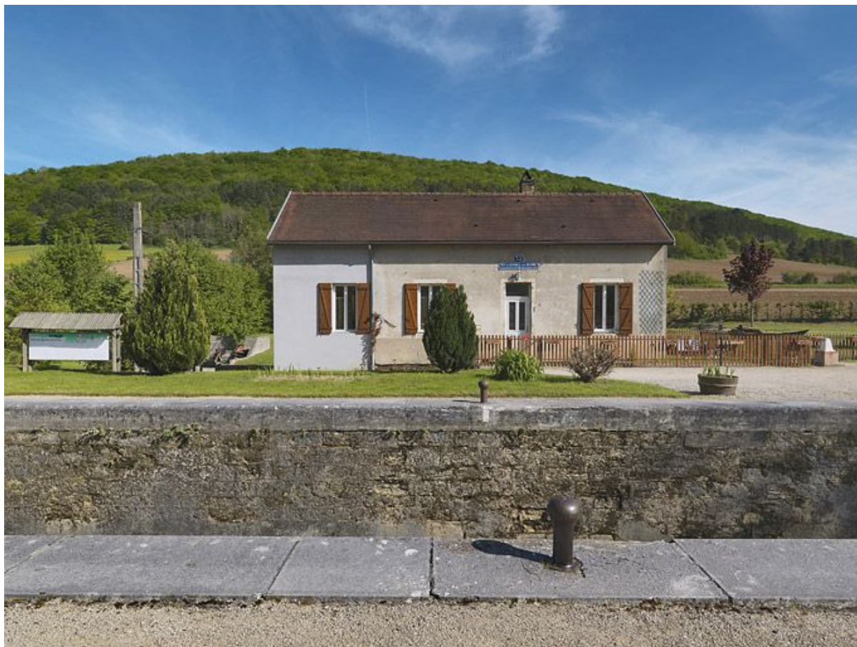
Maison éclusière de face.
