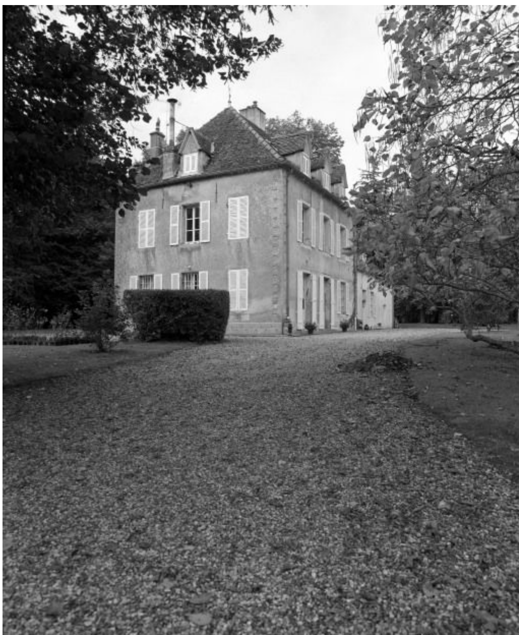
Logis, élévation gauche.
